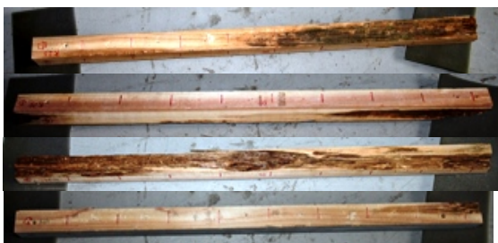
写真4 45mm×45mm(床根太用)部材の劣化状態 上から、K23_1、K24_1、K25_2、K26_3。ただしK25_2は打撃面の側面の写真
