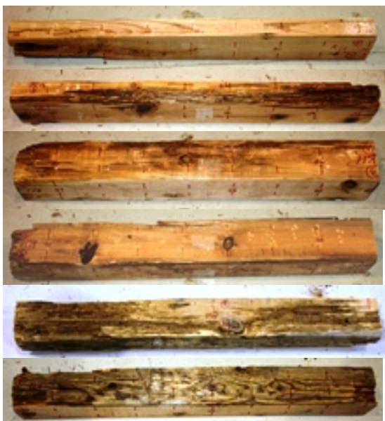
写真5 105mm×105mm、105mm×45mm(柱、土台、間柱)部材の劣化状態 上から、K19_3、K18_3、K11_4、K11_5、K02_3、K02_1。ただし、K11_4とK11_5、K02_3とK02_1の異なる面
