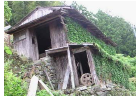
写真4 外観・玄関の方から
