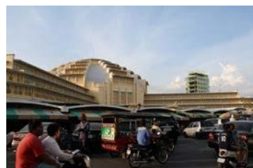
▲図⑬-2. アプローチ部分
