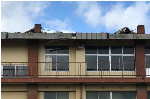
(a)被害全体写真
