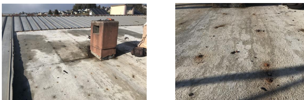
(a) 外装材を剥がした屋根の様子(煙突部) (b) 煙突手前のボルト断面の様子
