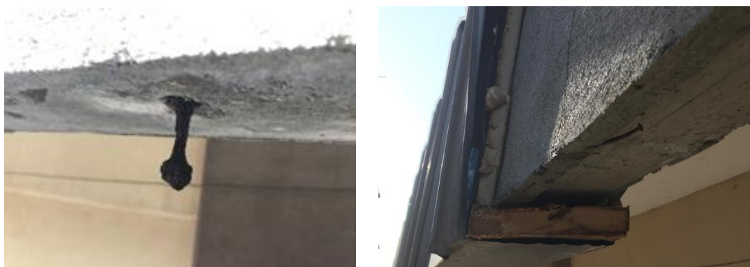
図 4 屋根留め付け具の劣化の様子
