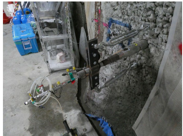
図4 岩盤側壁に取り付けた注水用の装置
