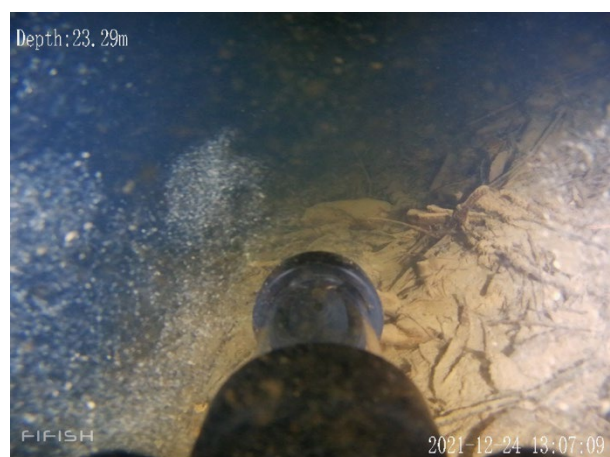
写真-2 水中ドローンによる宇連ダム内の観測
