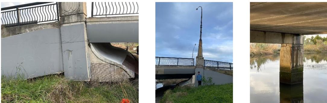
地震によってひび割れが入った状態の橋脚↑
