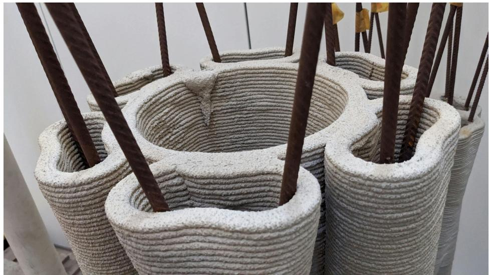
図 9: 3D プリンターを用いた鉄筋コンクリート（流し込み前）
