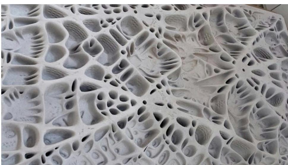
図 5: トポロジー最適化を用いたスラブ設計
