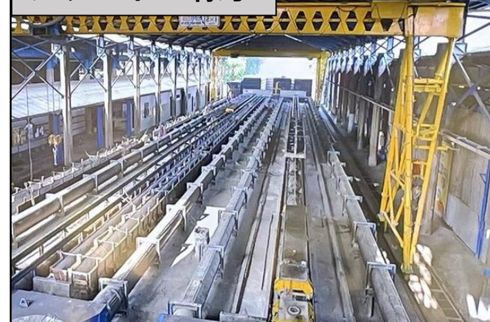
プラントの様子
