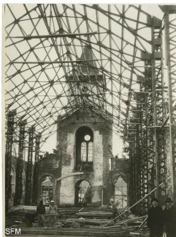
②1950年12月の工事写真。Dec. 1950: Steel frame of columns and beams
