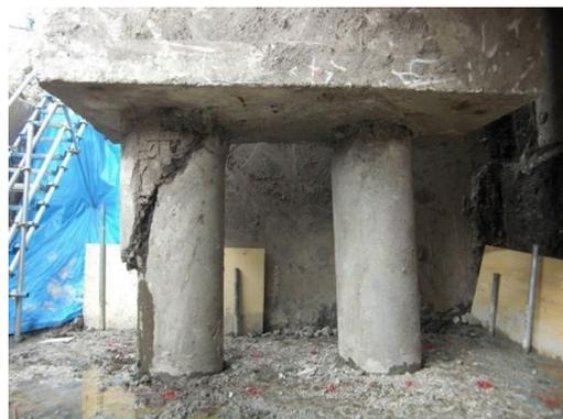
図1 地震による基礎被害<sup>3)</sup>
