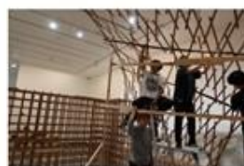
7. 屋根ユニット結合
