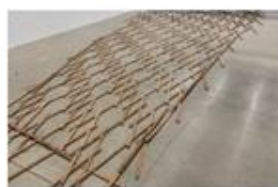
5. 屋根縁材取り付け
