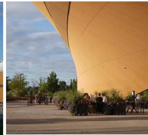
フィンランド産のスプルース材を用いて描かれたファサード。有機的な曲線が特徴的な外観をしている。
