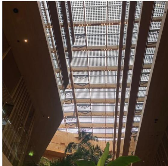
自動開閉式のガラス天井。室温が上がれば開いて空気を逃がし、気温が低い時は閉じる。
