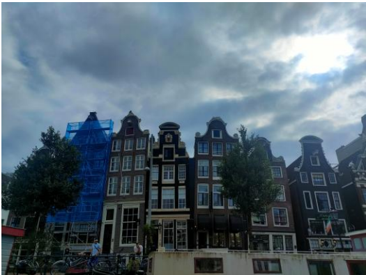
沈下により傾いた建物
