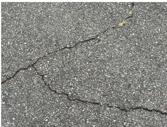
図1 道路のクラックの実物のサンプル 図2 斜角柱でモデル化されたクラックのパラメータ
