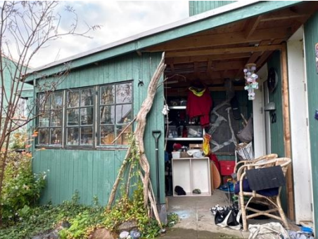
風除室を増築し、資材置き場として活用
