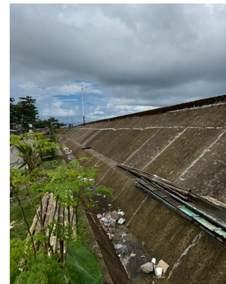
台風ヨランダの後に JICAの支援により建設された防潮堤
