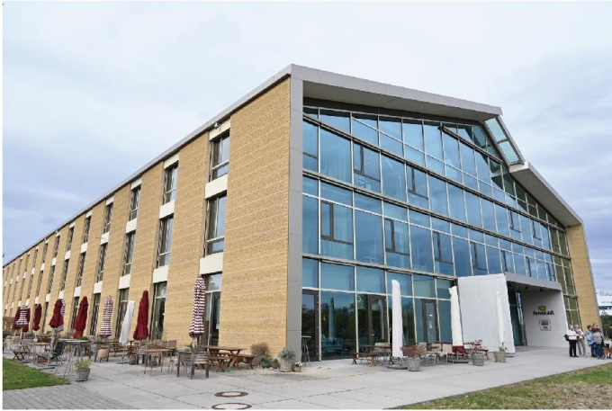
写真1 正面ファサード
