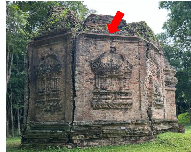
建造物が外側へ広がり崩壊するのを防止するために一周はめられた鉄枠
